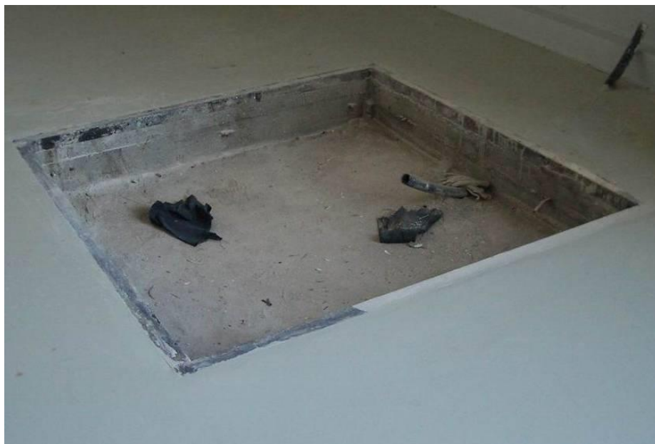
Рис. 9 – Внешний вид приямка для весов МЕРА-ВТП
